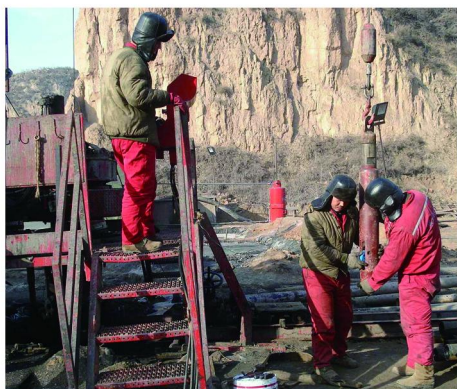
图2 山西晋中煤层气试验井施工现场
