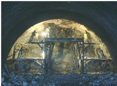
图 6 区域定人、定位进行钻孔作业现场
