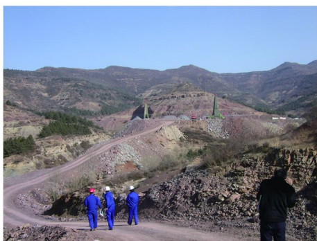
图1 进、回风井筒检查孔同时施工
