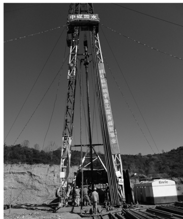
图1 中煤第四水文地质队山西水源井施工现场
