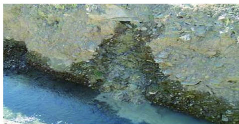
图4 桩号0+493处灌浆,探渗沟0+430处串浆
