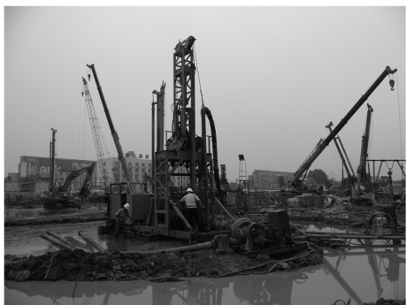
图2 钻机在武汉市工地施工现场
