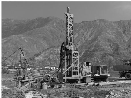
图1 钻机在甘肃省陇南市兰渝铁路施工现场
