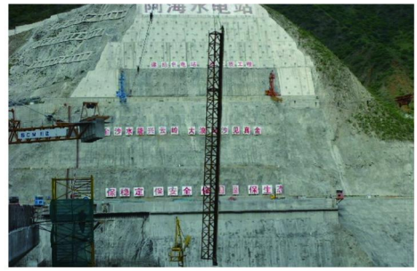
图2 缆机起吊固定在拖架的长心样
