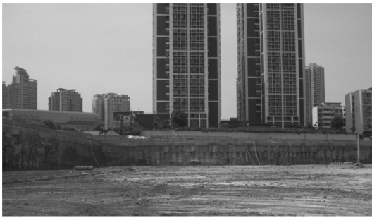
图12 基坑开挖现场图
