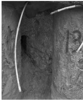
图6 桩间孔洞
