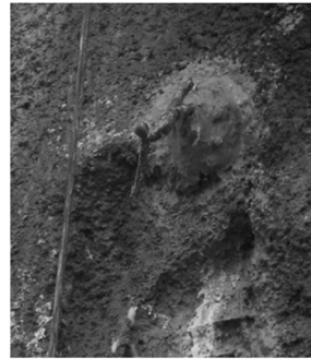
图7 喷注发泡剂
