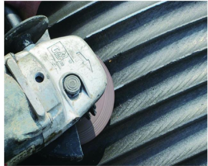
图 8 绳槽两侧出现锋利尖角时需及时修磨
