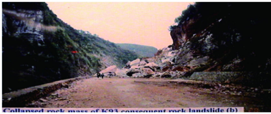
图 2 K93 + 600 顺层岩石滑坡坡脚
