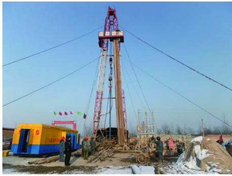
图5 地热井气举反循环施工现场
