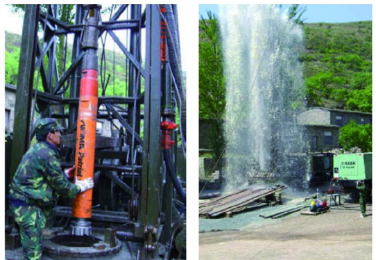
图 4 地热井浅孔段气动潜孔锤钻进现场
