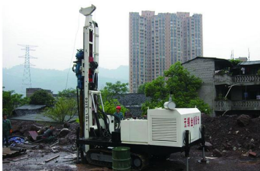
图8 绳索取心钻进施工现场
