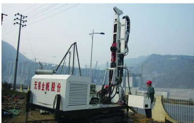
图7 监测孔施工现场
