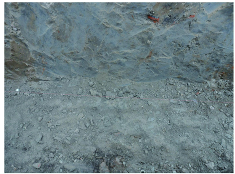
图 2 侵入墙体范围内的三轴搅拌桩
