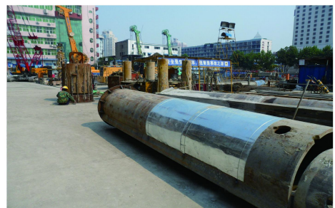
图5 接头管绑设薄铁皮
