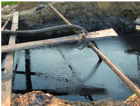
图 3 正在使用的泥浆池
