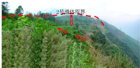
图3 2号滑体现状全貌照片
