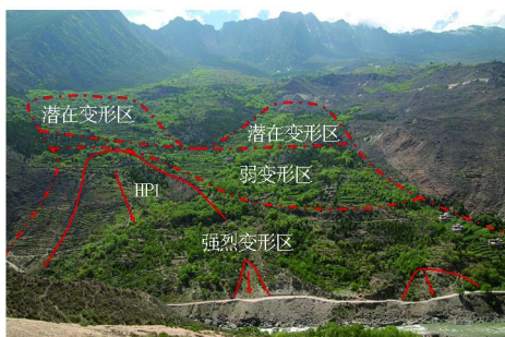
图1 甲居滑坡全貌图
