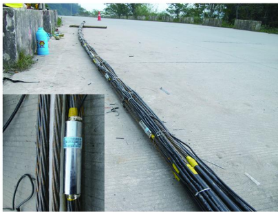
图 2 锚索制作及磁通量传感器的安装
