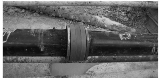
图4 套在套管上的遇水膨胀橡胶圈
