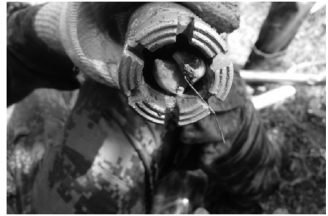
图6 浅钻施工过程中堵钻情形
