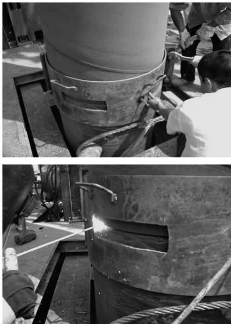
图4 套管对接扶正及点焊图片
