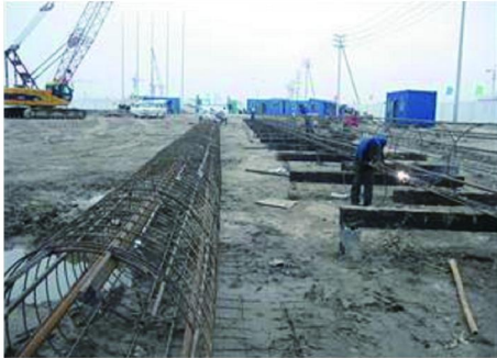
图2 钢筋笼全长加工平台
