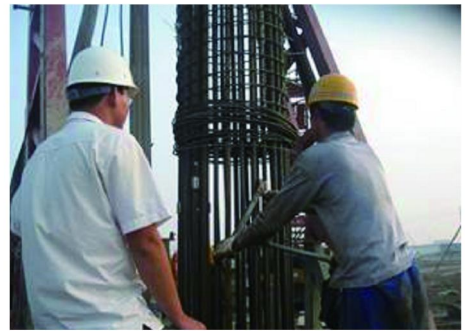
图6 钢筋笼孔口直螺纹对接
