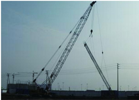
图3 钢筋笼6点起吊
