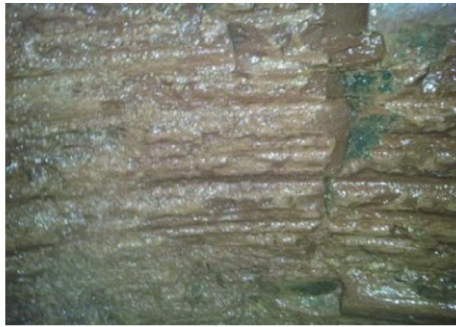
图3 清渣完成孔壁情况
