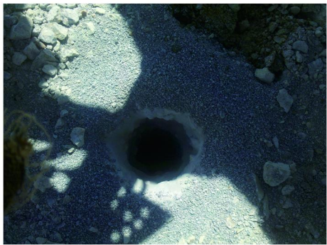
图 2 洗孔时钻孔周围排出的岩屑
