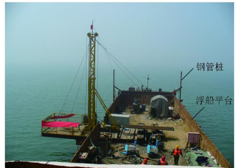
图5 定位钢管桩组装实体应用照片
