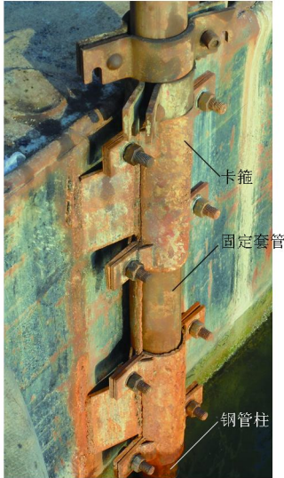
图4 定位钢管桩实体应用照片
