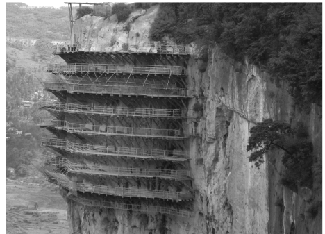
图3 锚索完工后的照片
