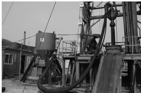
图 8 新密和成煤矿瓦斯抽排井气举反循环钻井现场
