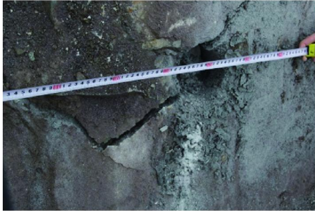
图 3 试验后裂缝最大长度
