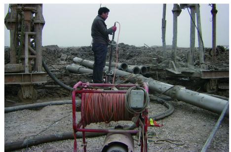
图 5 倾斜度检测测斜仪准备下放孔中
