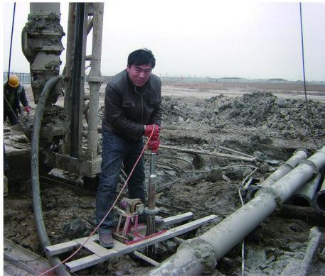
图 2 孔径检测井径仪准备下放孔中
