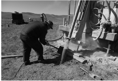
图7 下入孔口井壁管
