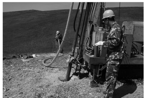
图 6 开孔后孔口状似漏斗
