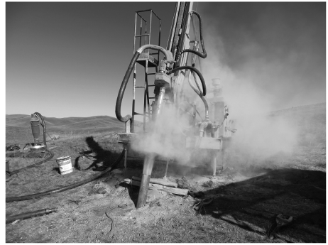
图10 反吹时孔口吹出大量粉尘
