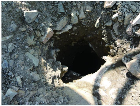
图1 已回填场地现状
