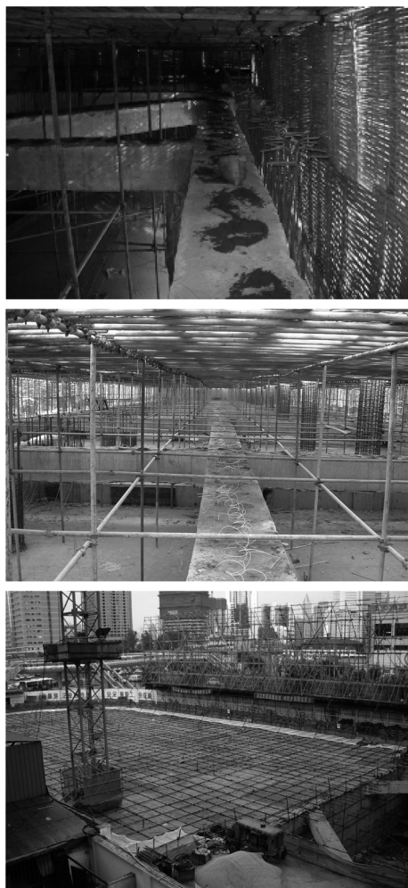
图7 露天爆破防护棚搭设实例照片
