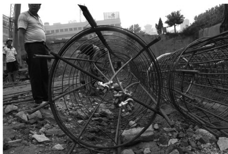
图 4 底部段钢筋钢绞线笼
