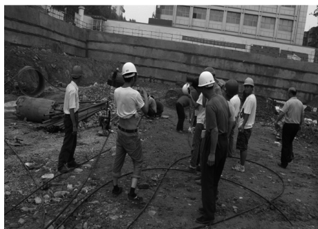
图 2 按量好的长度切割钢绞线
