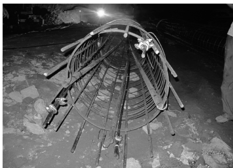
图 5 上部一段钢筋钢绞线笼
