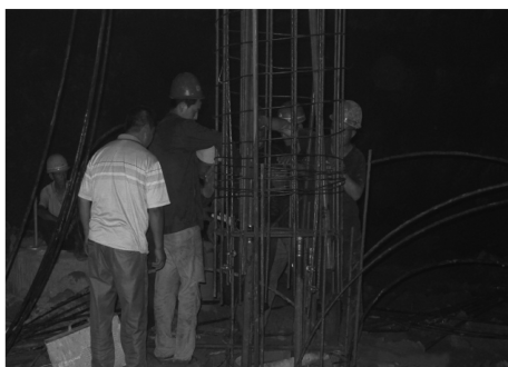
图 6 孔口连接钢筋钢绞线笼
