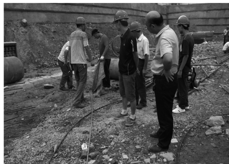
图 3 将下部钢绞线去皮清洗油脂
