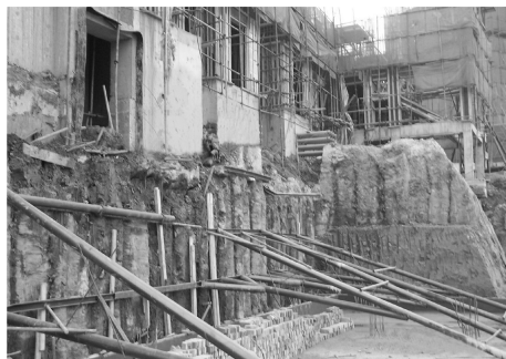
图4 基坑内钢管斜撑
