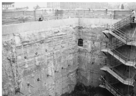
图3 锚索加固悬臂式支护
