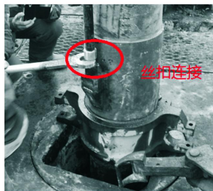
图 5 丝扣连接测管
