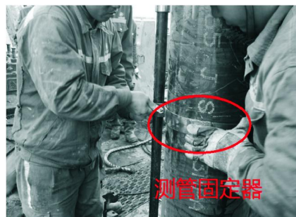
图 6 测管固定器固定套管和测管
