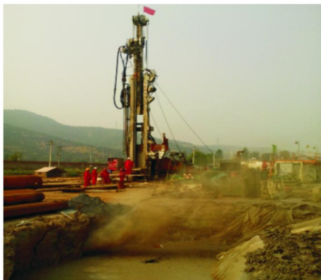
图5 反循环排渣效果
