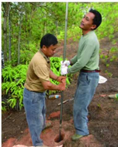
图2 赣南钻的施工
