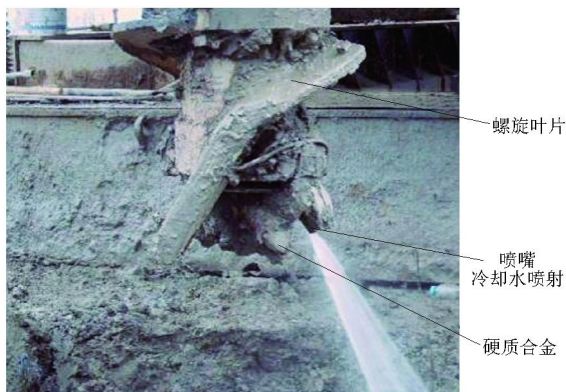
图5 长螺旋钻头冷却水喷射
