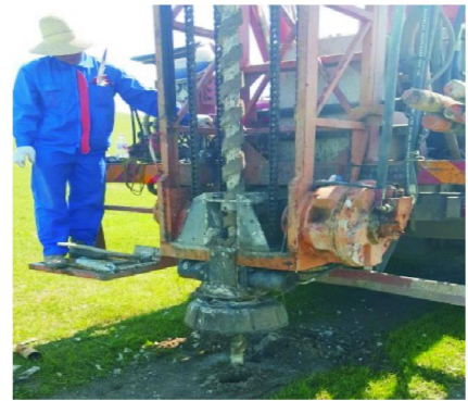
图 10 螺旋钻杆钻进
