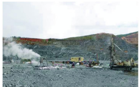
图5 现场钻进情况
