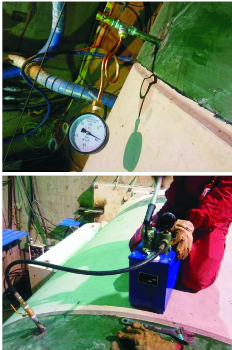
图6 隧道管节修复装置耐压试验过程
