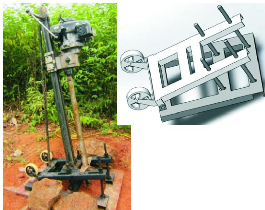
图 4 斜孔用钻机底座示意图及施工现场
