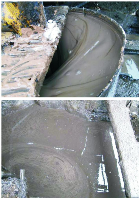
图4 现场配制泥浆
