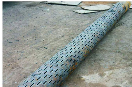
图2 现场加工抽水过滤管
