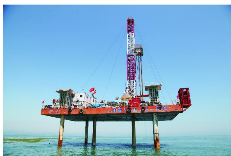
图8 “探海1号”大陆架科学钻探平台施工现场图
