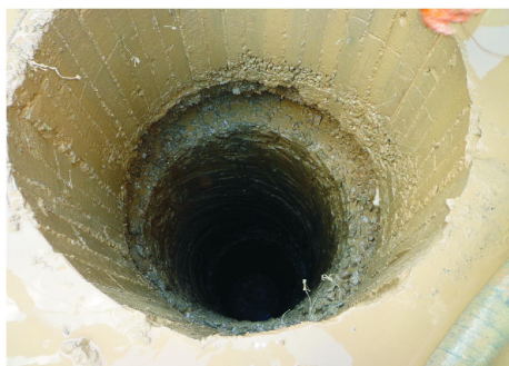
图 1 旋挖钻机第一次钻孔完成
