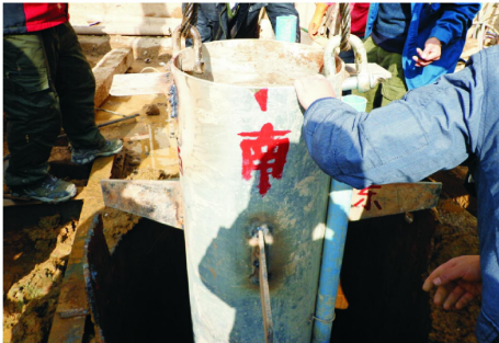
图5 钢管立柱下放
