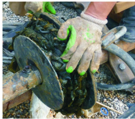
图5 制作止水装置
