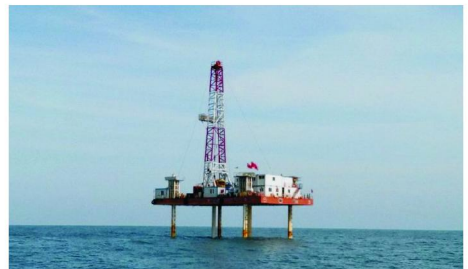
图 4 南黄海大陆架科学钻探现场
