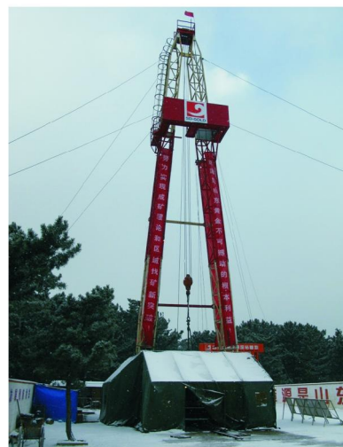
图 1 4006.17 m“中国岩金勘查第一深钻”施工现场
