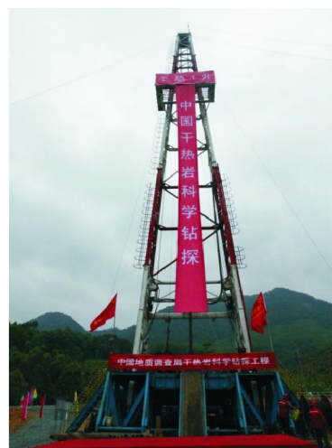
图 5 东南沿海深部地热(干热岩)科学钻探现场
