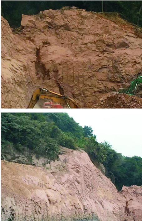
图6 边坡预裂效果图
