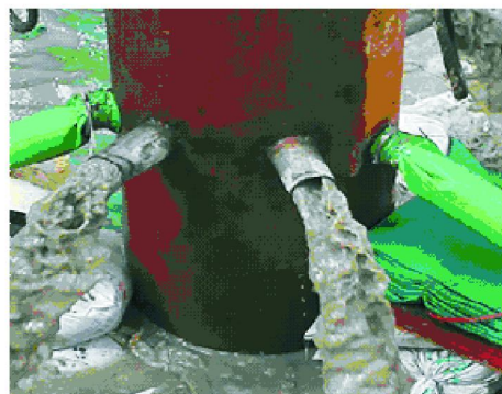
图4 洗孔至钢套管底,溢流口喷水
