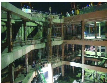
图2 打入钢套管
