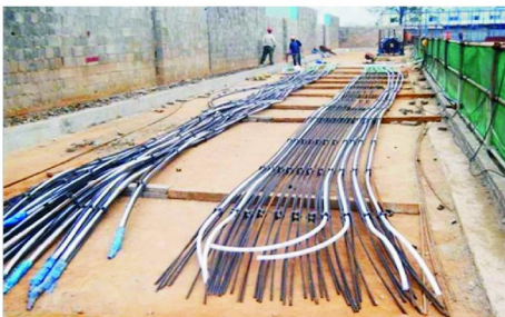
图4 普通锚索杆件中设置1根二次注浆管
