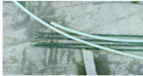
图5 锚索杆件中设置2根注浆管
