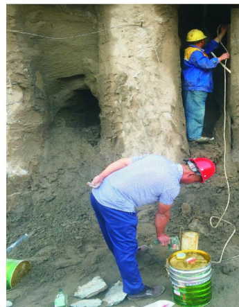
图7 对引流管进行聚氨酯注浆封口
