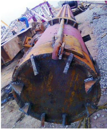
图2 底节耐磨管注浆管布置
