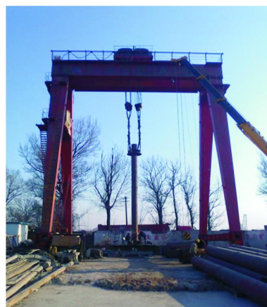
图1 耐磨管安放实景
